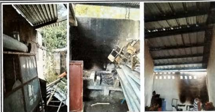
Foto 8: MODULO DE COCINA Vista Interna cubierta de lamina troquelada cal 26 y estructura metalica a base de costaneras. Muros con aplicación de acabado repello + cernido y pintura final.
