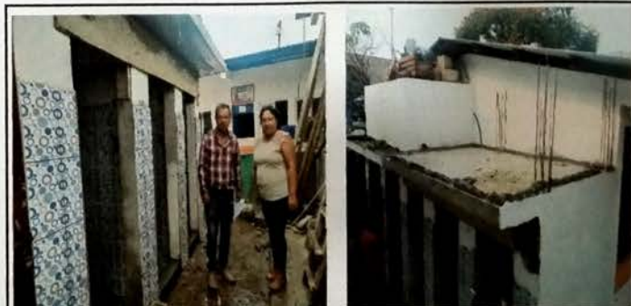
Foto 12: Vista de proceso constructivo de modulo de servicios sanitarios. Aplicacion de azulejo en muros y fraguado de fundicion de losa en servicios sanitarios.
