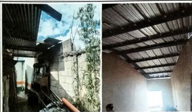
Foto 7: MODULO DE COCINA Vista Interna cubierta de lamina troquelada cal 26 y estructura metalica a base de costaneras. Muros con aplicación de acabado repello + cernido y pintura final.
