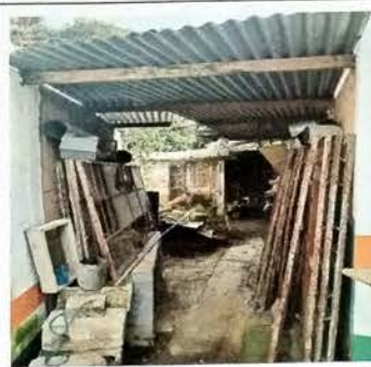
Foto 2: Vista interior del area de cocina donde se esta remodelando, al los laterales se puede observar con se tienen los muebles de concreto en etapa de fundicion. Se esta levantadon celosia en pared de fondo.
