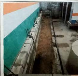
Foto 6: Vista de muro de refuerzo a la par de modulo de aula, vista lateral izquierda y vista lateral derecha.
