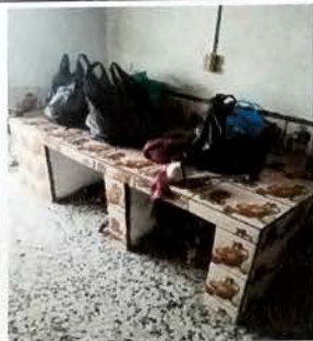
Foto 3: Vista de bases de concreto con aplicacion de azulejo .
