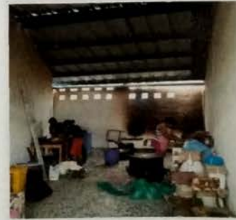
Foto 4: Vista interior de modulo de cocina remozada, con instalacion de piso ceramico, muros con aplicacion de repello + cernido + cubierta de lamina troquelada cal 26 y estructura de metal a base de costanteras.
