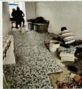
Foto 5: Vista interior de cocina con instalacion de piso de granito
