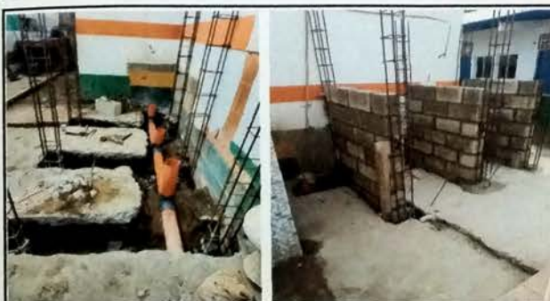
Foto 11: Vista del proceso de modulo de servicios sanitarios, con instalacion de sistema de drenajes.
