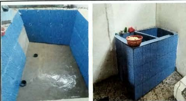
Foto 9: Vista de proceso de ejecucion de pila con aplicación de azulejo,
